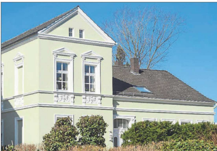
Das Sonderpreis der Stadt Bad Lippspringe geht in | Platz 7. Der Malerbetrieb Krüger setzte die Fassade
