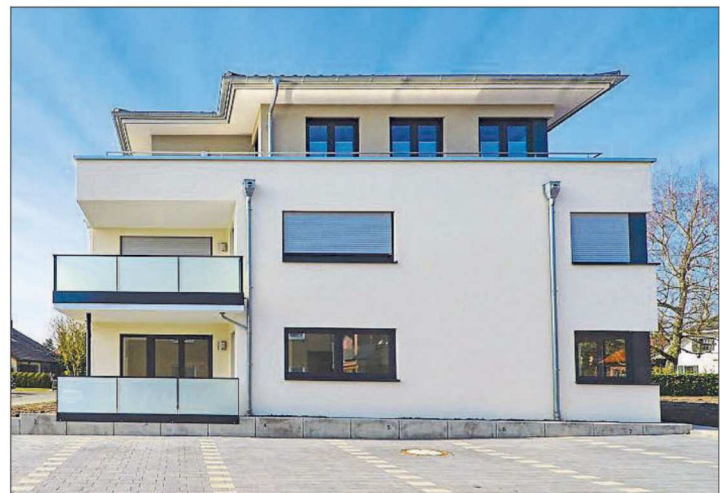
Dieses Mehrfamilienhaus von Josef Westphal | dem die Stadt Delbrück auszuweisen. Die Fassa-
